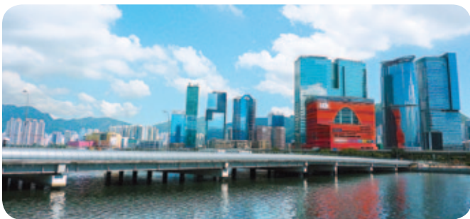
啟德橋 Kai Tak Bridge
